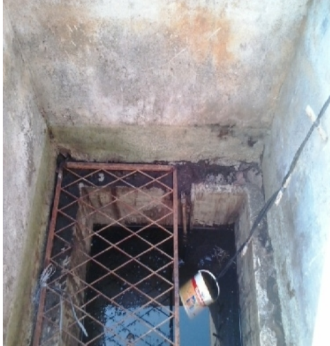
Gambar 21. Pengurasan pada reaktor Hidrolisis Asidogenesis untuk bahan Baku organik.
