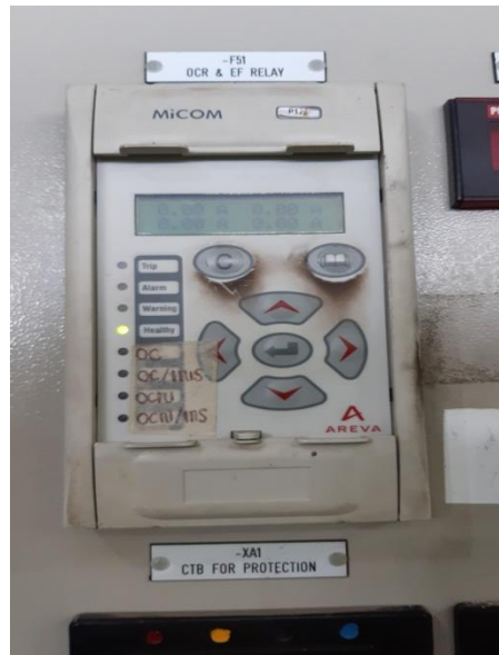
Gambar 2.11 Gambar Relay OCR dan GFR
