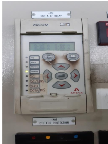
Gambar 2.6 Gambar Relay OCR dan GFR
