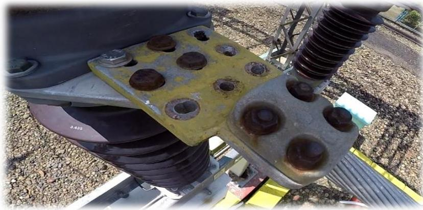
Gambar 2.6 Adanya Cat pada Klem Peralatan di *Switchyard*<sup>2</sup>
