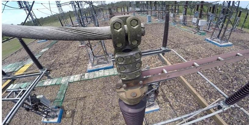
Gambar 2.9 Adanya Polutan pada Klem Peralatan di *Switchyard*<sup>2</sup>
