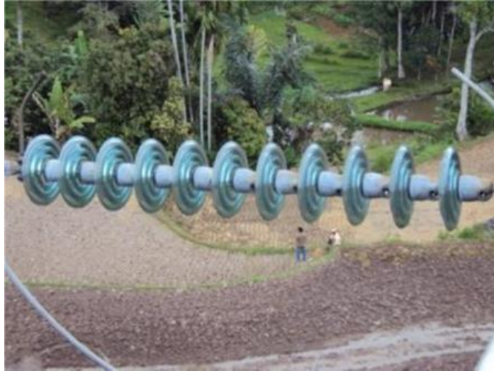
Gambar 2.12 Insulator gelas/ kaca
