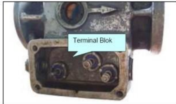
Gambar 2.20 Terminal Pada Rele Jansen
