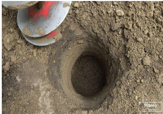
Gambar 2.5 Lubang Hasil Pengeboran Biopori (Sumber: Lit. 5)
