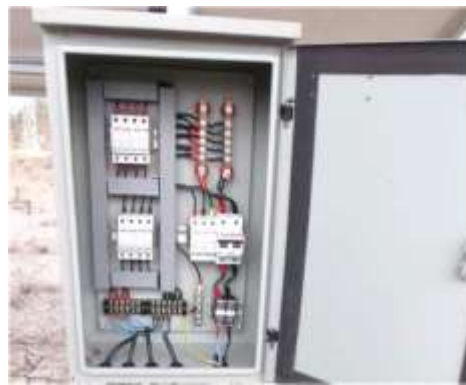
Gambar 2.18 Gambar Kotak Penggabung
