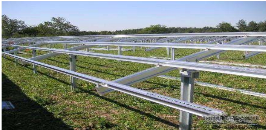
Gambar 2.10 Gambar pondasi fotovoltaik
