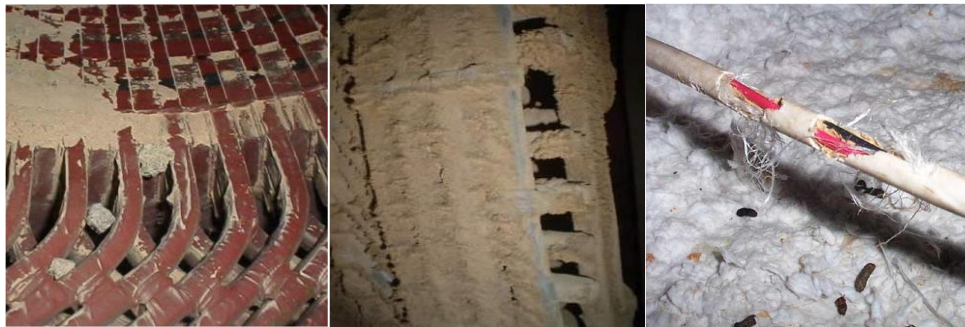
Gambar 2.21 Kondisi Operasi Motor (Kontaminasi & Bio Hazard )
