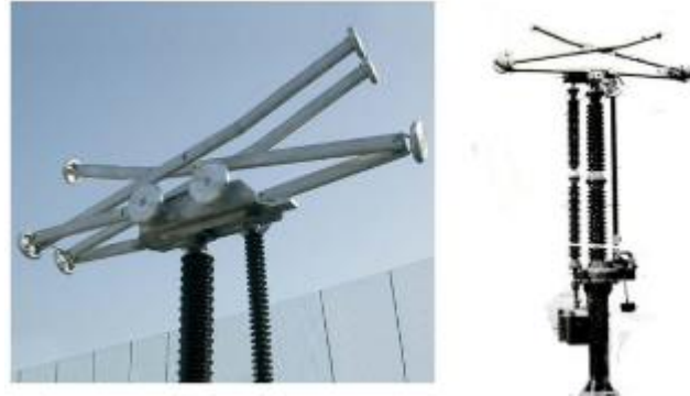
Gambar 2.24 Pemisah Pantograph.
