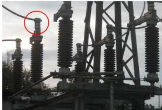
Gambar 2.25 Terminal Utama Klem
