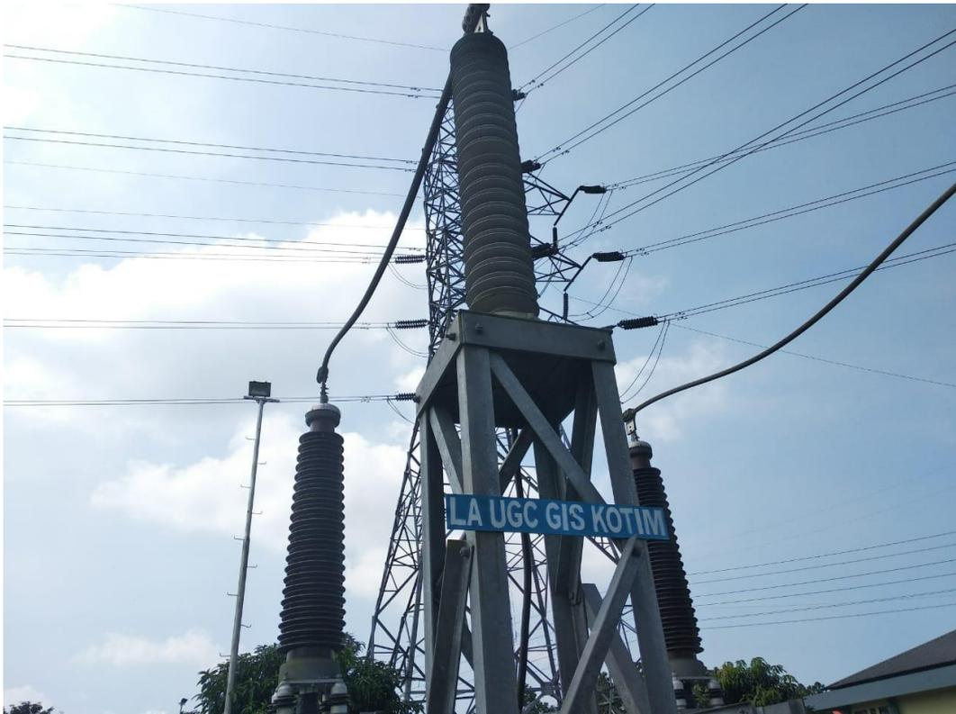
Gambar 2.2 Arrester Pada Gardu Induk Kenten
