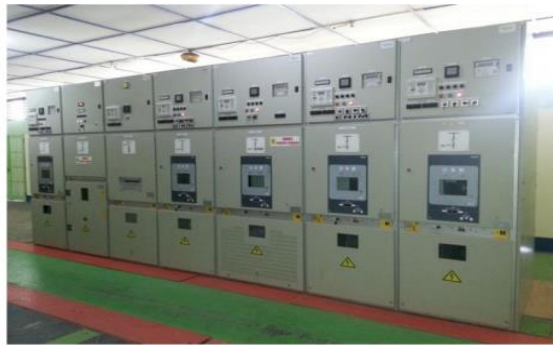
Gambar 2.1 Kubikel Tegangan Menengah
