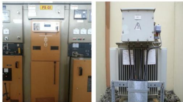
Gambar 2.5 Kubikel Pemakaian Sendiri di GIS Kotim
