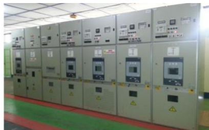
Gambar 2.15 Kubikel Tegangan Menengah
