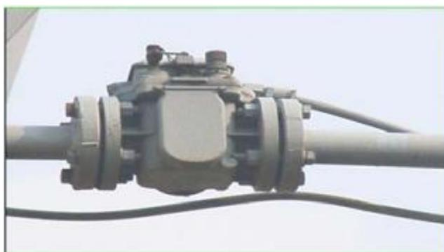
**Gambar 2.13 Bentuk Fisik dari Relay Bucholtz**
