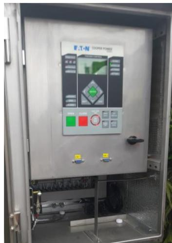
Gambar 2.8 Kotak Panel RTU pada LBS
