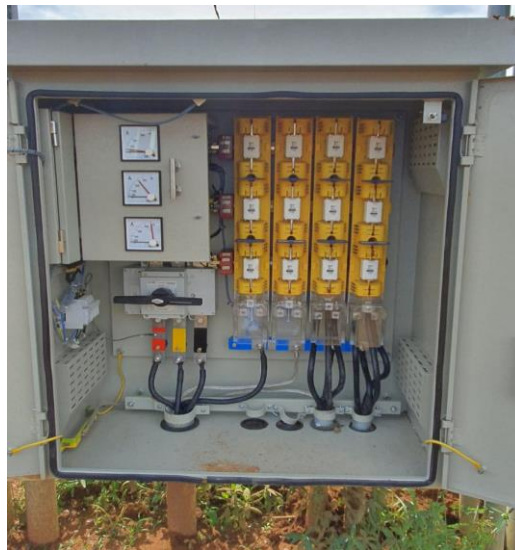
Gambar 2. 9 Komponen Utama Bagian Bawah Gardu
