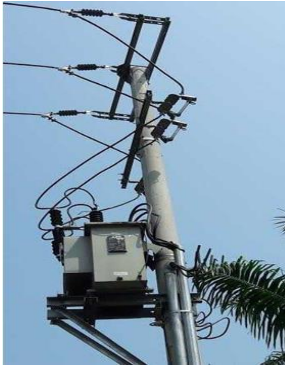
Gambar 2. 8 Komponen Utama Bagian Atas Gardu
