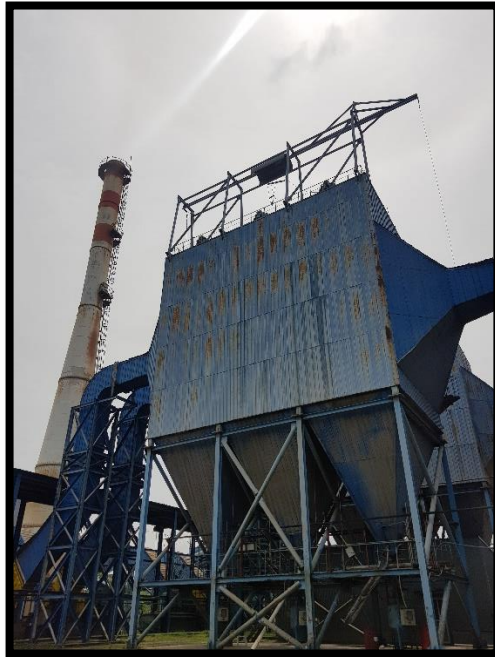
Gambar 2. 20 Electro-static Precipitator (Sumber: Dokumentasi Pribadi)
