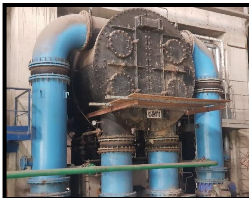
Gambar 2. 6 Kondensor (Sumber: Dokumentasi Pribadi)
