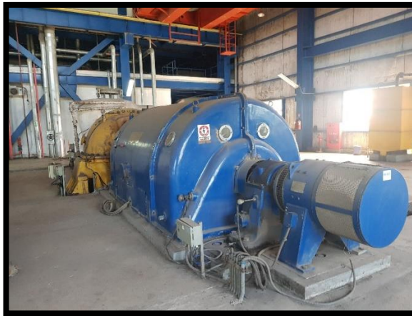
Gambar 2. 32 Turbo-Generator pada PLTU (Sumber: Dokumentasi Pribadi)
