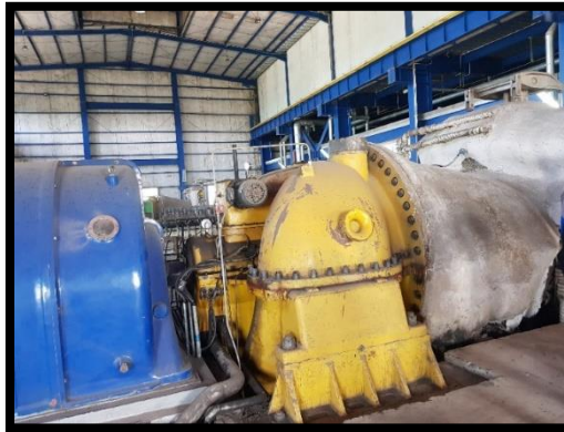
Gambar 2. 29 Turbin Uap STG (Sumber: Dokumentasi Pribadi)
