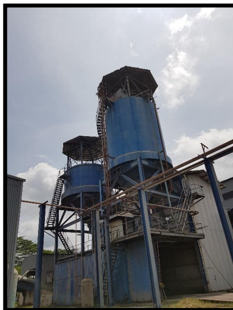
Gambar 2. 19 Ash Silo (Sumber: Dokumentasi Pribadi)
