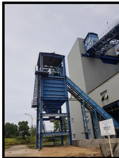
Gambar 2. 18 Slag Silo (Sumber: Dokumentasi Pribadi)
