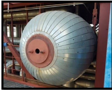
Gambar 2. 27 Steam Drum (Sumber: Dokumentasi Pribadi)
