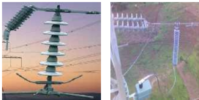
Gambar 2.15 Arrester di Saluran Transmisi
