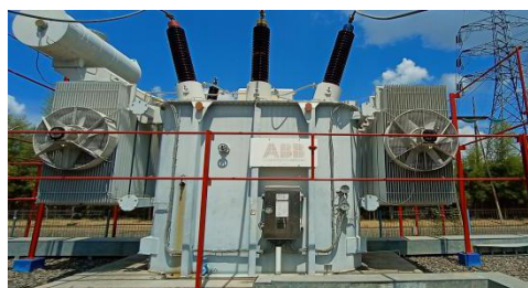
Gambar 2.1 Transformator Daya.
