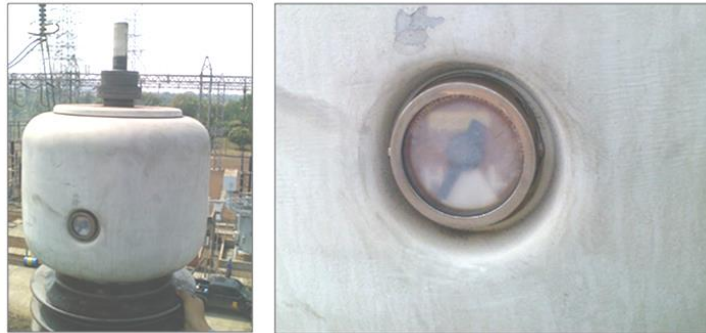
Gambar 2.16 Indikasi Level Minyak Bushing
