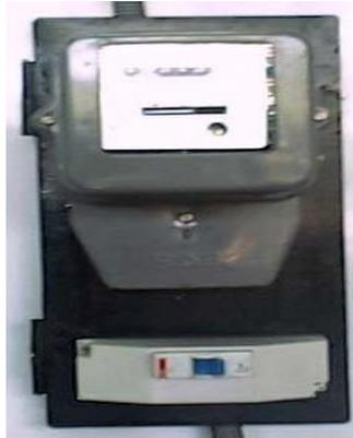
Gambar 2.12 Kwh Meter 1 Phase<sup>15</sup>
