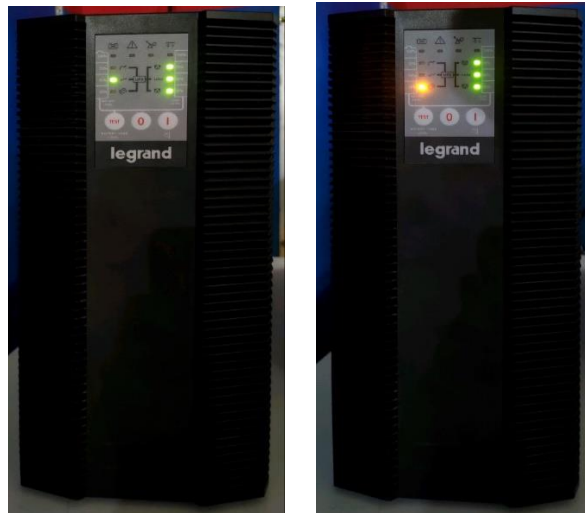
Gambar 2.25 A. Kondisi saat bypass melalui UPS, B. Kondisi saat menggunakan baterai
