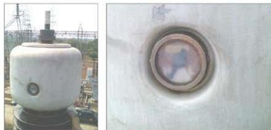
Gambar 2.10 Indikator level minyak bushing
