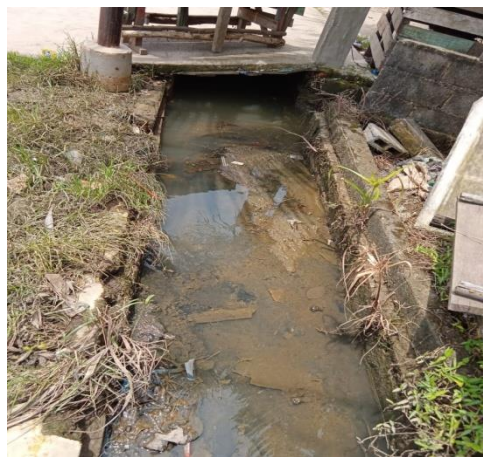
Gambar 1.3 Saluran drainase yang berisi endapan
