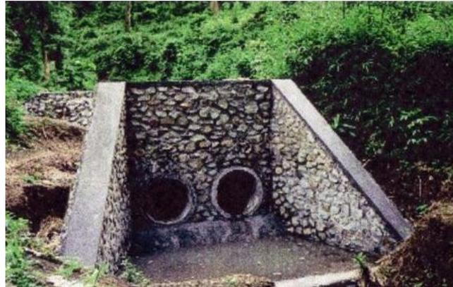
Gambar 2. 26 Bangunan Pembuang Silang
