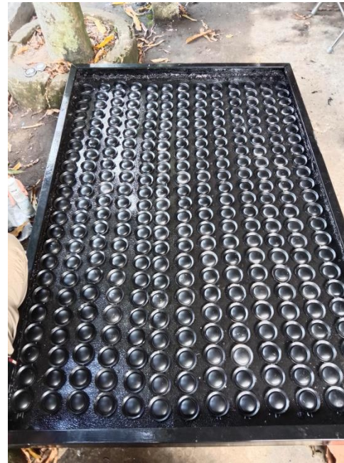
Gambar 16. Pemasangan Alas Dasar Kaleng Pada Panel
