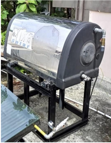
Gambar 17. Tangki Penyimpanan Air (Aluminium)
