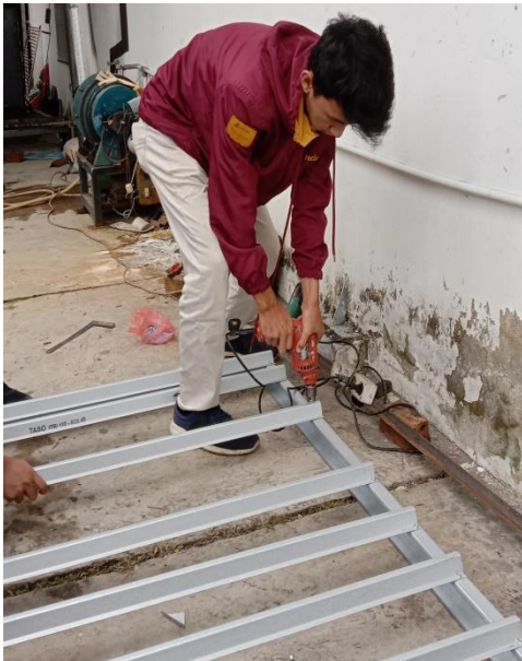
Gambar 11. Pembuatan Frame Panel
