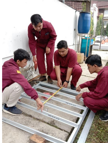
Gambar 8. Merangkai Potongan Taso untuk Membentuk Frame Panel
