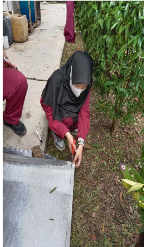
Gambar 10. Pemotongan Plat Alkan untuk Alas Panel
