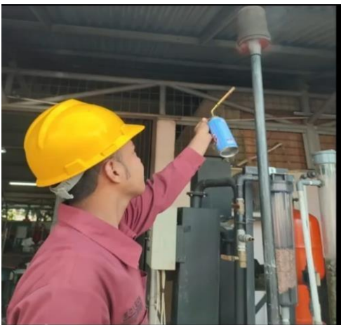
L3.20 Menyulut Api Pada Flare Stack
