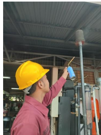
Uji Nyala Api di Flare Stack
