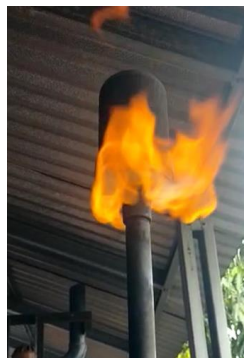
Hasil uji nyala api pada flare stack
