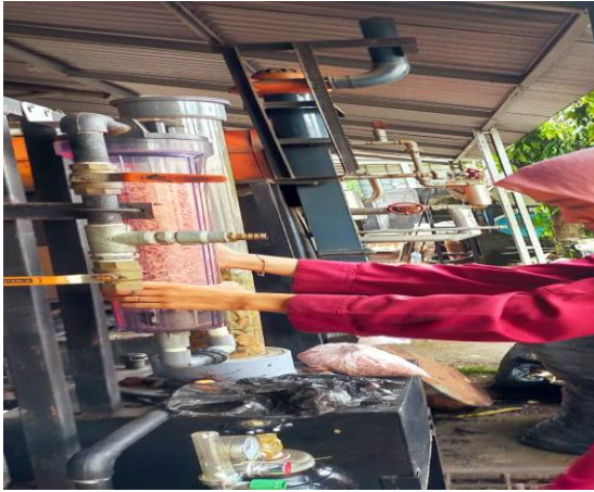
L.3.11 Memasang tangki filter yang sudah diisi media filter
