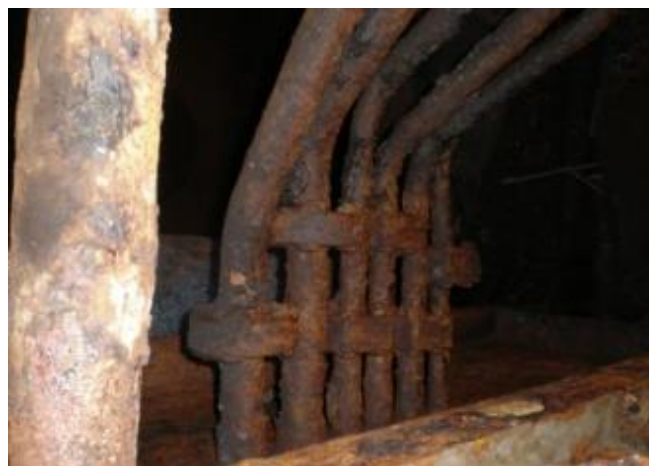
Gambar 2.3 Korosi Seragam pada Pipa Ballast
