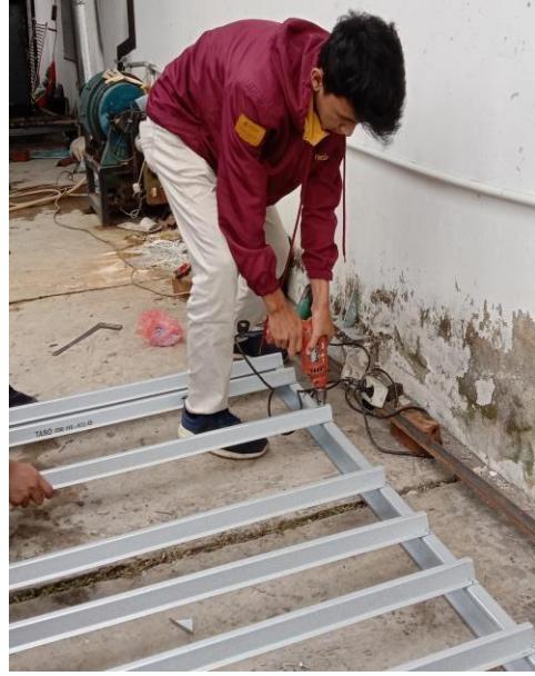
Gambar 11. Pembuatan Frame Panel
