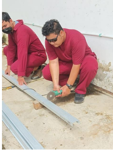
Gambar 7. Pemotongan Tiang Taso
