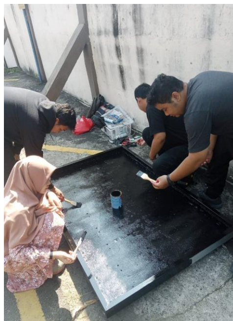
Gambar 14. Pemberian Cat Warna Hitam Pada Panel
