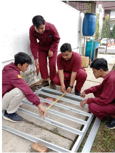
Gambar 8. Merangkai Potongan Taso untuk Membentuk Frame Panel
