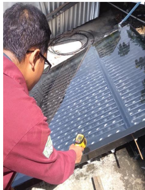
Gambar 28. Pengukuran Suhu Panel
