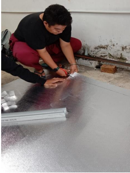
Gambar 9. Pemotongan Alkan
