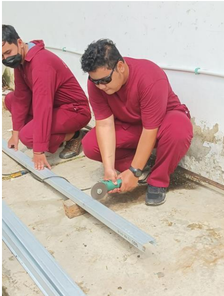
Gambar 7. Pemotongan Tiang Taso
