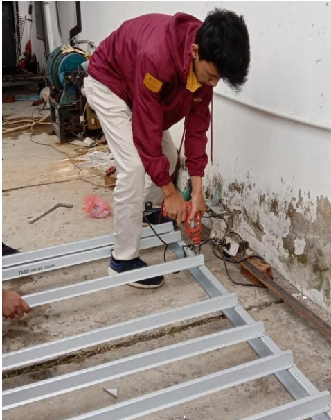
Gambar 11. Pembuatan Frame Panel
