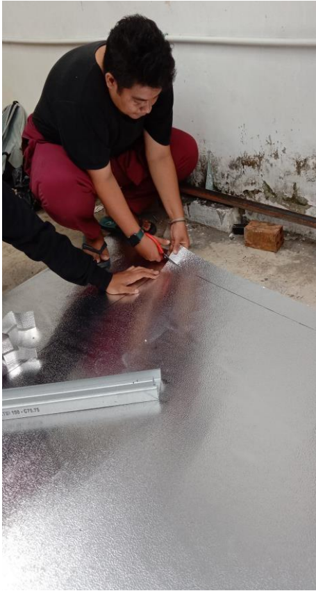
Gambar 9. Pemotongan Taso
