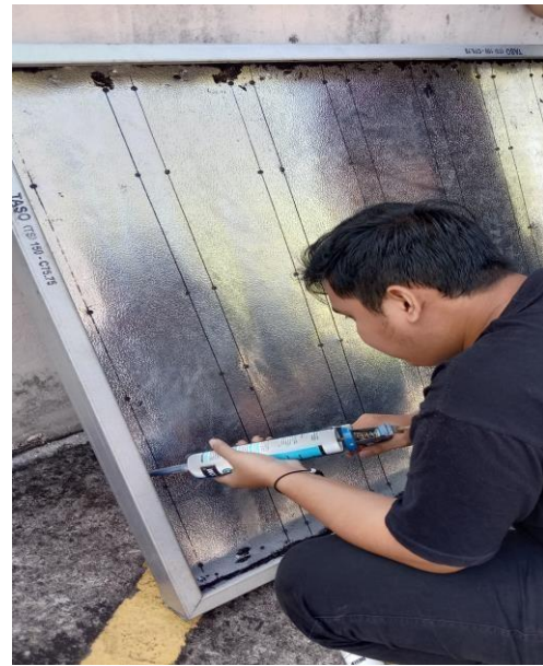
Gambar 14. Pemberian Lem Silicon Pada Lubang Agar Panel Kedap Udara
