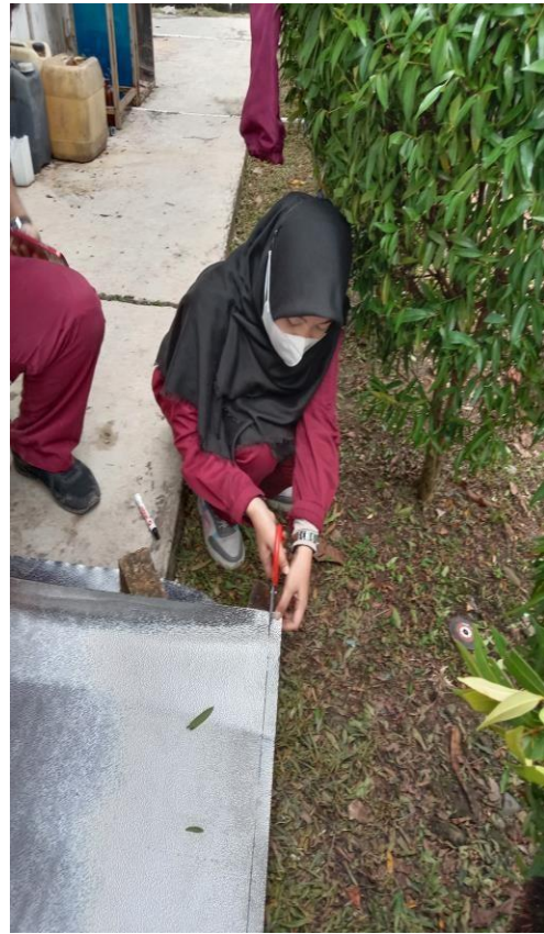
Gambar 10. Pemotongan Material Taso untuk Alas Panel
