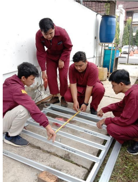
Gambar 8. Merangkai Potongan Taso untuk Membentuk Frame Panel
