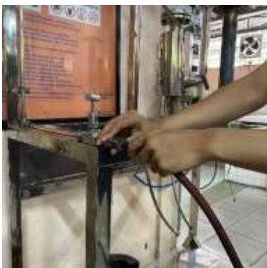
Menginjeksi Gas Hidrogen
