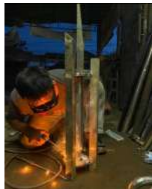
Penyambungan Pipa dengan Flange
