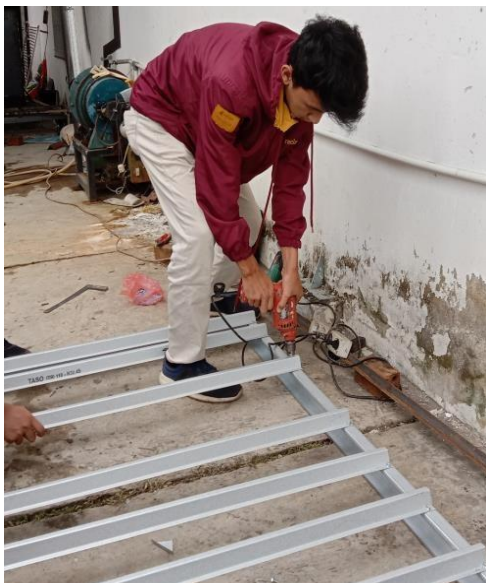
Gambar 5.11. Pembuatan Frame Panel
