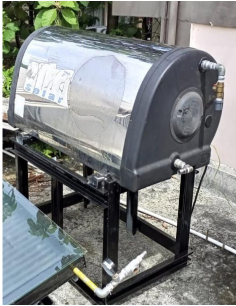
Gambar 5.17. Tangki Penyimpanan Air
