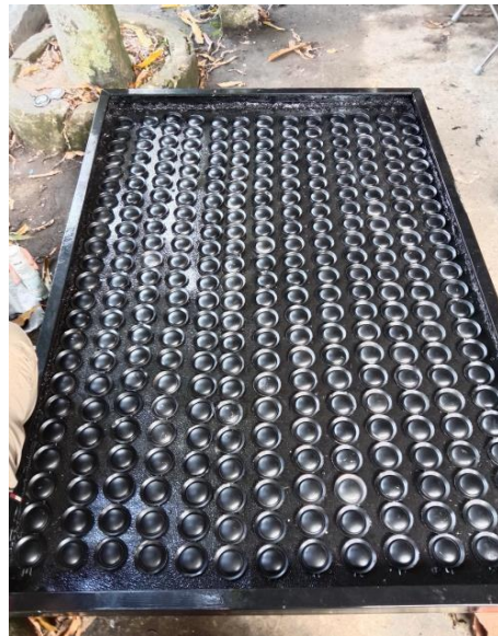
Gambar 5.16. Pemasangan Buntut Kaleng Pada Panel
