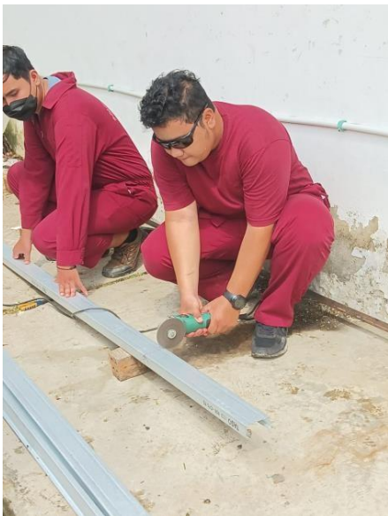
Gambar 5.7. Pemotongan Tiang Taso
