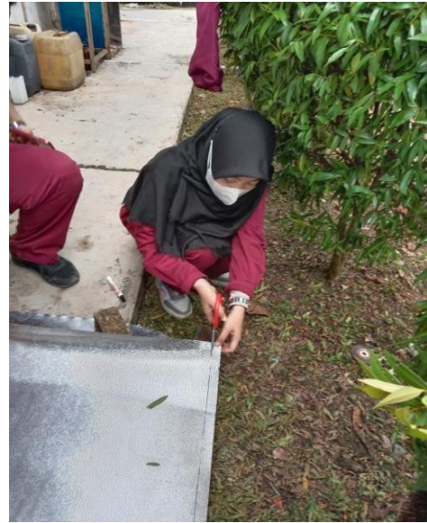
Gambar 5.10. Pemotongan Material Taso
