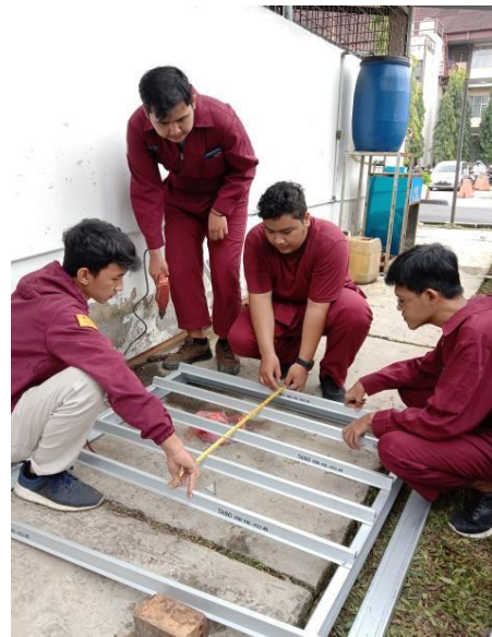
Gambar 5.8. Merangkai Potongan Taso untuk Membentuk Frame Panel
