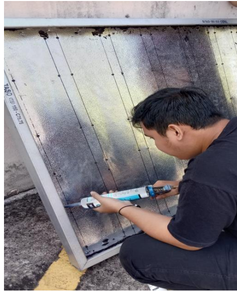
Gambar 5.14. Pemberian Lem Silicon Pada Lubang Agar Panel Kedap Udara
