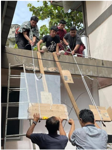
Gambar 5.21. Penaikkan Kaca Penutup Solar Panel Ke Tempat Percobaan
