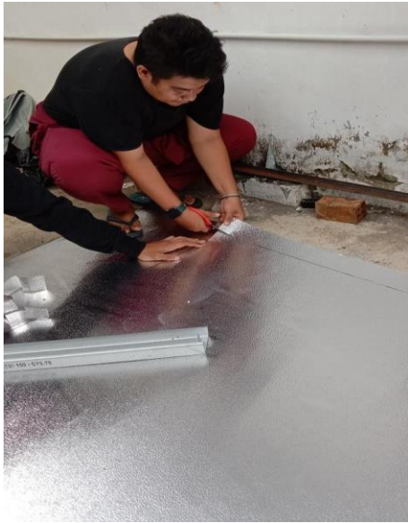
Gambar 5.9. Pemotongan Taso untuk Alas Panel
