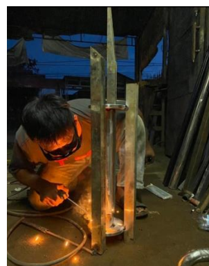
Penyambungan Pipa dengan Flange
