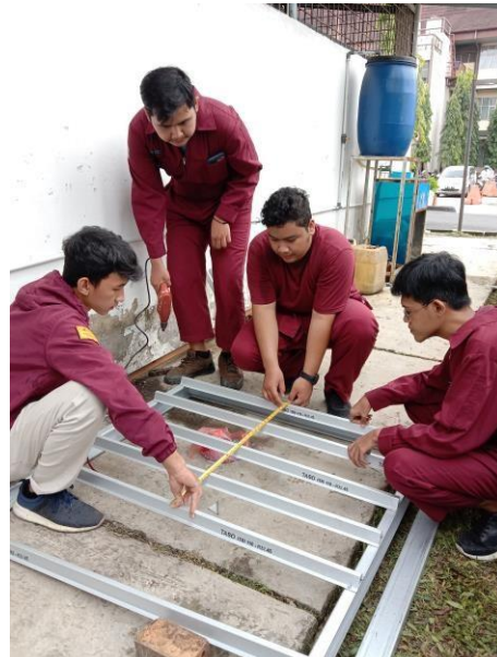
Gambar 8. Merangkai Potongan Taso untuk Membentuk Frame Panel
