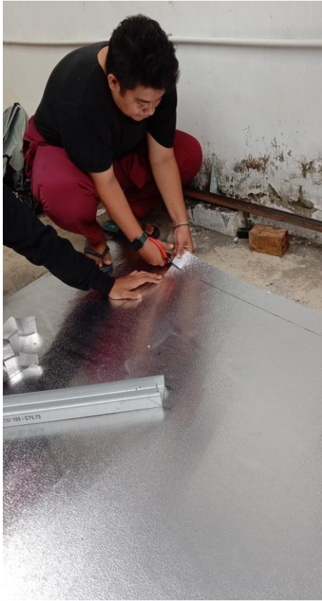
Gambar 9. Pemotongan Taso
