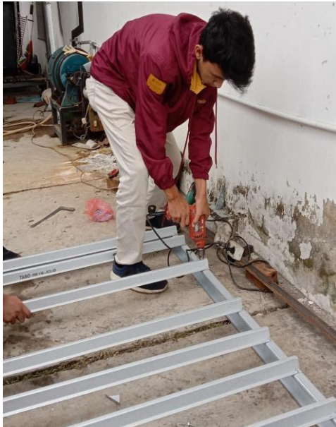
Gambar 11. Pembuatan Frame Panel
