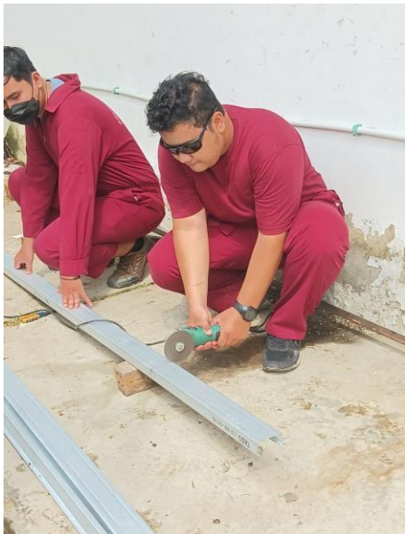
Gambar 7. Pemotongan Tiang Taso
