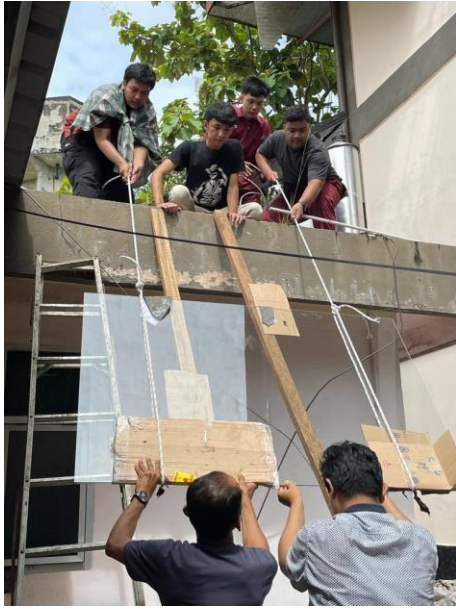
Gambar 21. Penaikkan Kaca Penutup Panel Ke Tempat Percobaan
