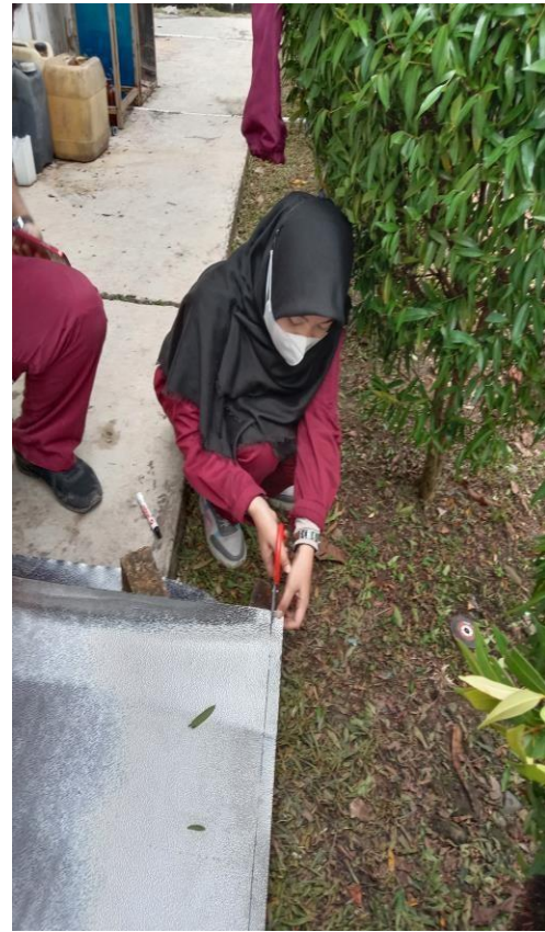
Gambar 10. Pemotongan Material Taso untuk Alas Panel
