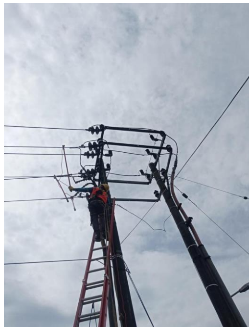
Gambar 5.1 Pembuangan Muatan Induksi pada Jaringan
