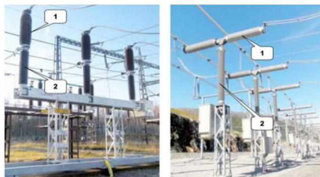
Gambar 2.9 Isolator pada Interrupting Chamber dan Support [2]
