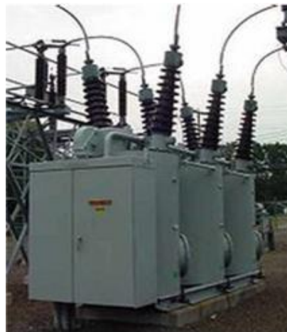
Gambar 2.3 PMT minyak [2]
