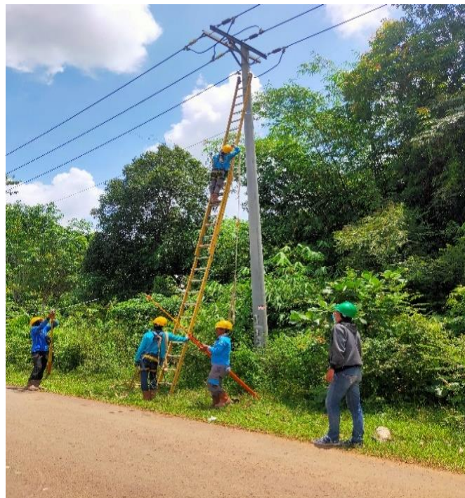
Gambar 2.2 Saluran Kabel Tegangan Menengah
