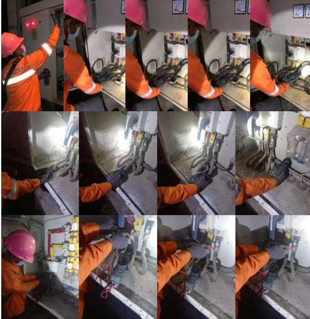
Lampiran 1. Proses Pengambilan Data Beban Puncak Gardu Distribusi di Penyulang Ducati.
