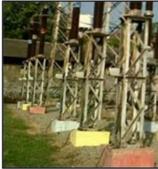
Gambar 2.11 Struktur Penyangga Lightning Arrester
