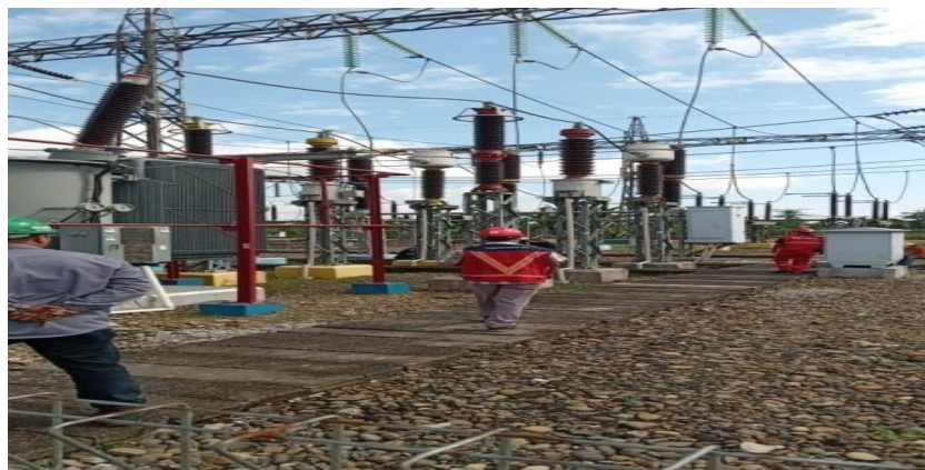
Gambar 2.13 Melakukan pemutusan / pelepasan arus transformator 11,5 kV dari PMT
