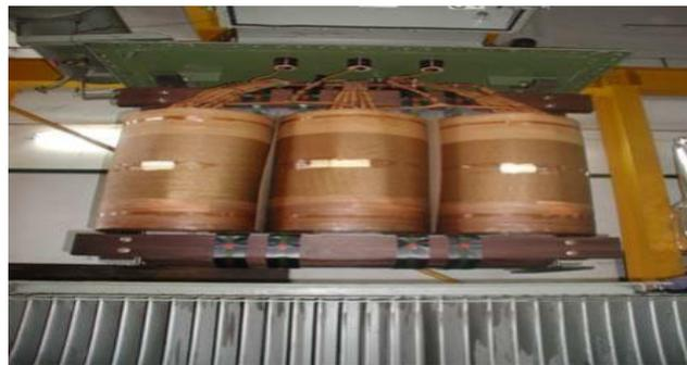
Gambar 2.5 Kumparan atau Belitan Transformator
