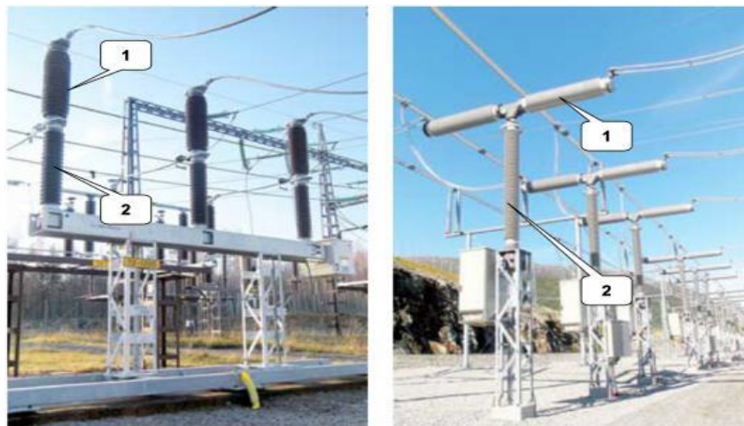
Gambar 2.8 Isolator pada Interrupting Chamber dan Support
