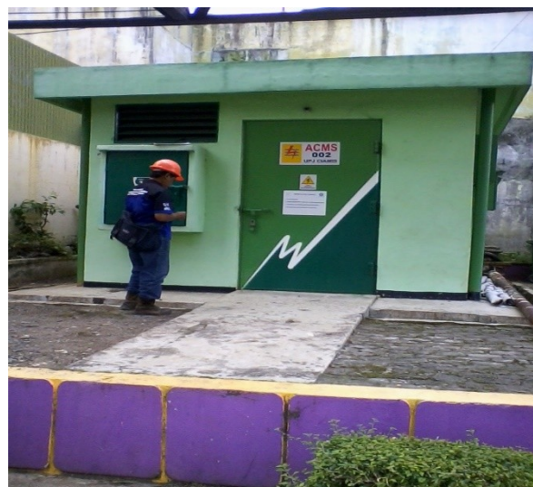
Gambar 2.6 Gardu Beton
