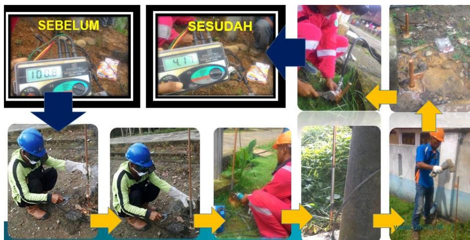
Gambar 2. 22 Perbaikan *Grounding* dengan Metode Inovasi Penyambungan Elektroda
