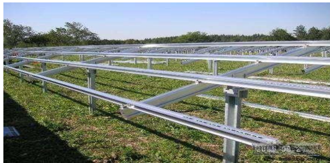
Gambar 2.17 Gambar pondasi fotovoltaic
