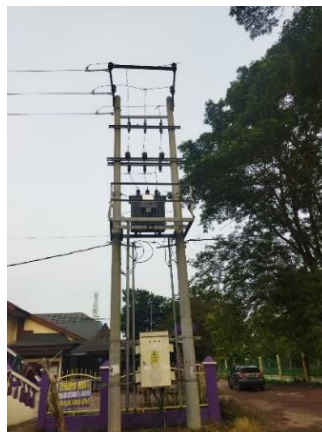
Gambar 2.4 Gardu Portal dan Diagram satu garis Gardu Distribusi Portal
