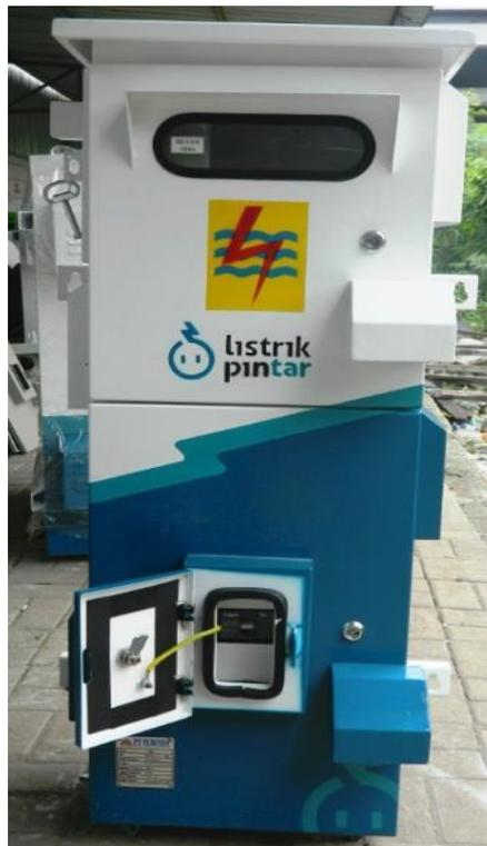
**Gambar 2.12** Tampak Luar Box APP Pengukuran Tak Langsung<sup>5</sup>
