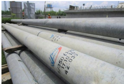
Gambar 2.9 Tiang Beton
