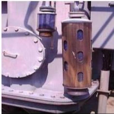
Gambar 2.8 Kontruksi alat pernapasan transformator
