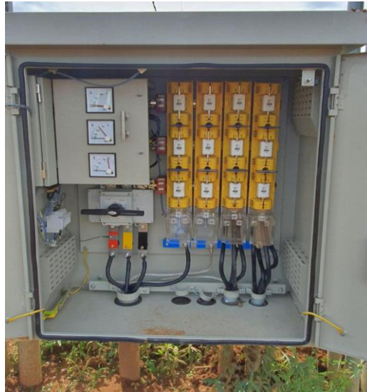
Gambar 2. 9 Komponen Utama Bagian Bawah Gardu
