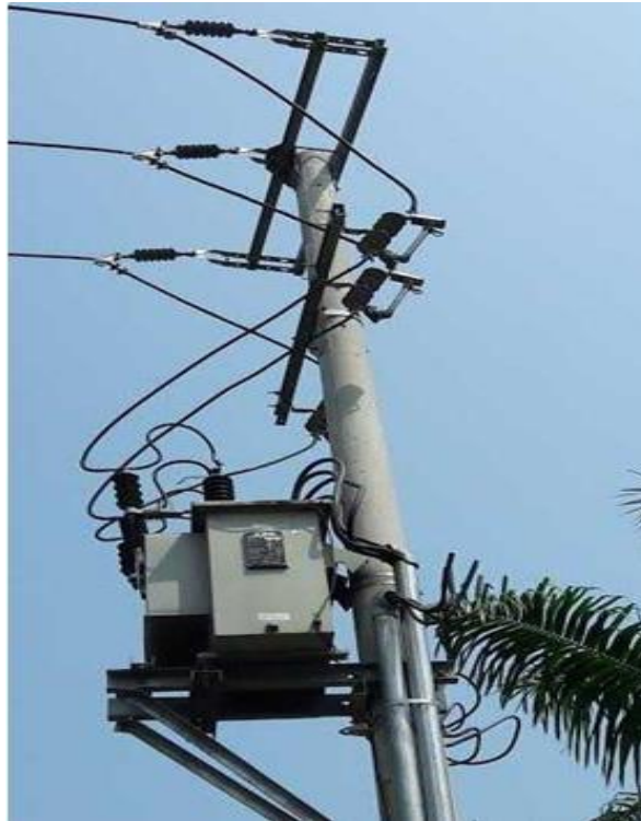
Gambar 2. 8 Komponen Utama Bagian Atas Gardu
